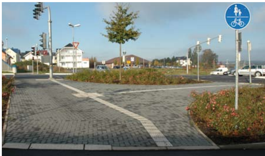
Das Leitsystem führt zum Ampelmast. Ab hier übernimmt die Signalanlage die Führung.
