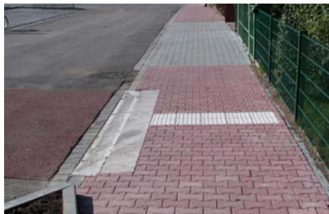
Querungsstelle in Zufahrtsstraße.
