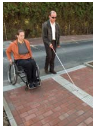
Eine getrennte Führung ist bei kleinem Fahrbahnnteiler nicht möglich.
