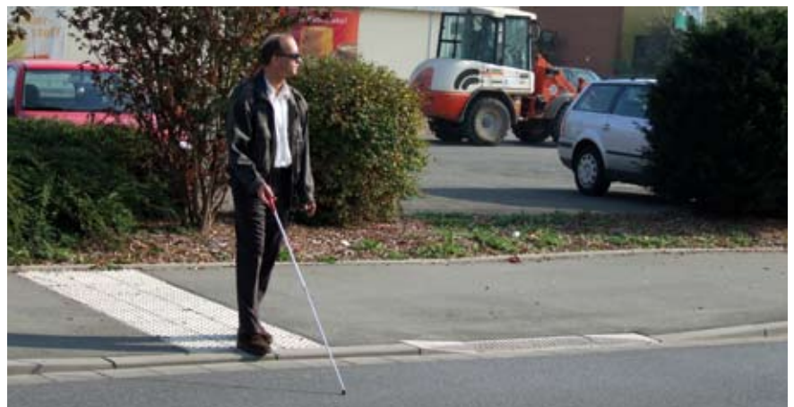
Ungesicherte Querungsstelle für Geh- und Sehbehinderte.
