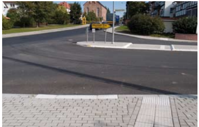
Einmündung der Landesstraße mit Fahrbahnsteiler.
