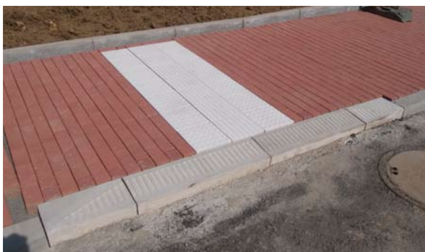
„Kasseler Rollbord“ mit Auffangstreifen.
