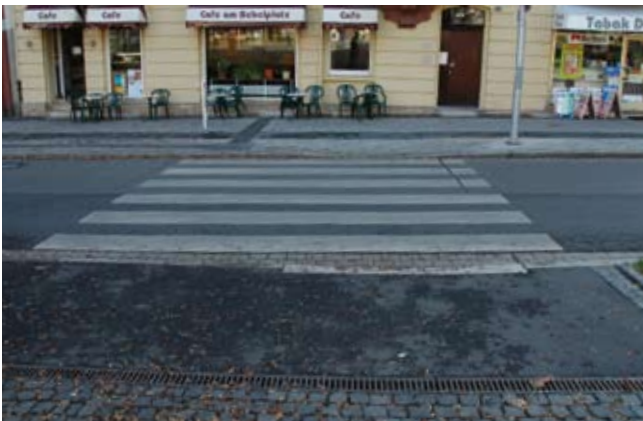
Der südliche Gehweg. Vom Aufmerksamkeitsfeld mit Noppenplatten führt ein Leitstreifen zu Bushaltestelle. Die Auffangstreifen vor dem Café und auf dem Platz ganz im Vordergrund wurden mit Basaltpflaster ausgeführt.
