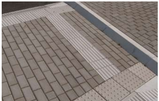
Auf der Mittelinsel wurde mit Rillen- und Noppenplatten experimentiert. Ausrichten können sich Sehbehinderte an den Schrägborden der Inselköpfe.
