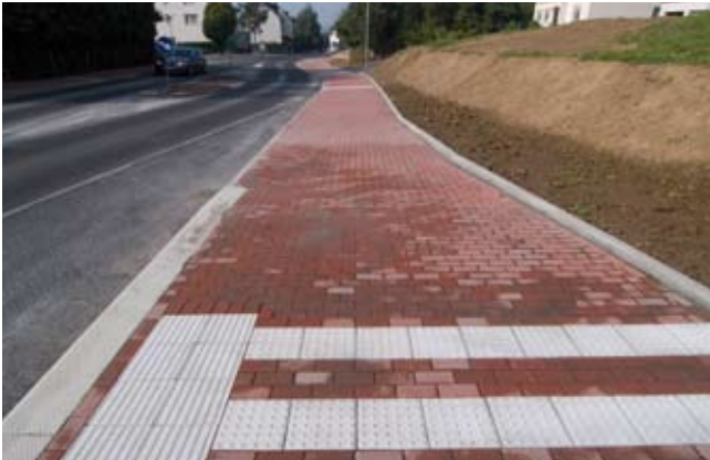
Der Auffangstreifen an der Haltestelle führt zum Einstiegsfeld mit Rillen.
