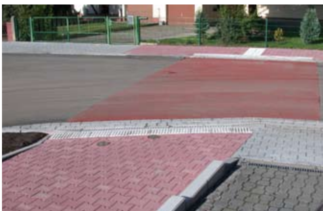
Übergang über die Zufahrt der Wendeschleife.
