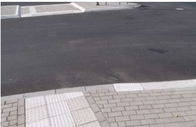
Südseite der Landesstraße. Auffangstreifen mit integriertem Richtungsfeld ermöglicht die Ausrichtung auch bei schräger Bordsteinkante.
