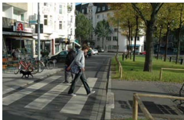
Nordseite. Das Aufmerksamkeitsfeld mit Basaltpflaster vor der Querungsstelle hat eine Tiefe von 90 cm in Laufrichtung, es ist zirka 2,00 m von der eigentlichen Querung. Die Rasenkante als natürliche Leitkante wurde mit Natursteinen zirka 3 cm über Gehwegniveau ausgeführt
