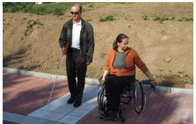
Da die Ausrichtung am Bordstein nicht möglich ist, wurden Rillenplatten in die Mitte des Auffangstreifens gelegt.
