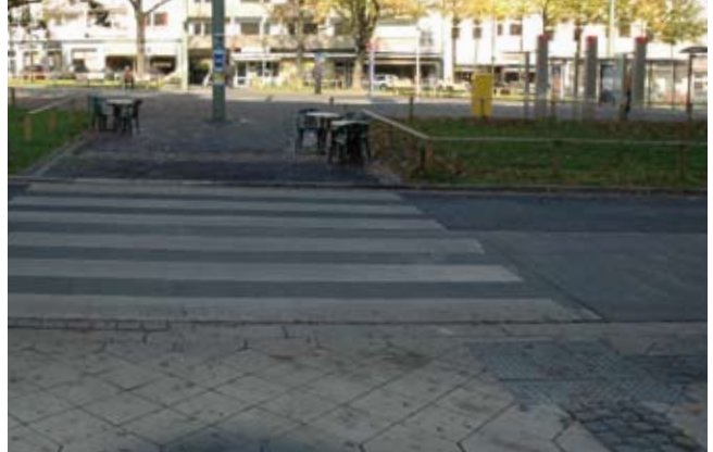
Der Blick von Süden über den Platz. Geh- und Sehbehinderte werden getrennt geführt. Im Vordergrund rechts der Auffangstreifen mit Basaltpflaster führt zur Querungsstelle für Sehbehinderte, die mit dem Aufmerksamkeitsfeld mit Noppen markiert ist. Hier beginnt der Leitstreifen zur Bushaltestelle.
