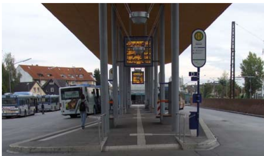
Blick vom Bahnhof in die Hauptachse des Omnibusbahnhofs.
