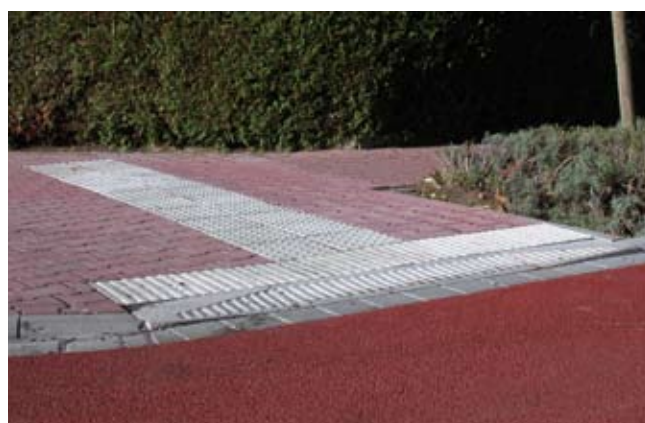
Eine Reihe Rillenplatten verstärkt die taktile Wirkung des Rollbords.
