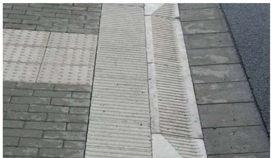
Kasseler Rollbord mit vorgelagerten Rillen- und Noppenplatten.
