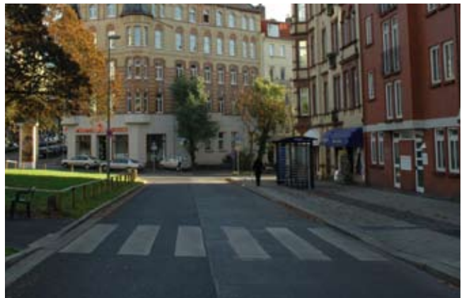
Die südliche Fahrbahn mit Bushaltestelle. Der breite dunkle Streifen in der Mitte des Gehwegs, auf dem das Wartehäuschen steht, wurde als gestalterisches Element eingefügt und hat keine besondere Leitfunktion. Der Leitstreifen verläuft parallel näher am Bord.
