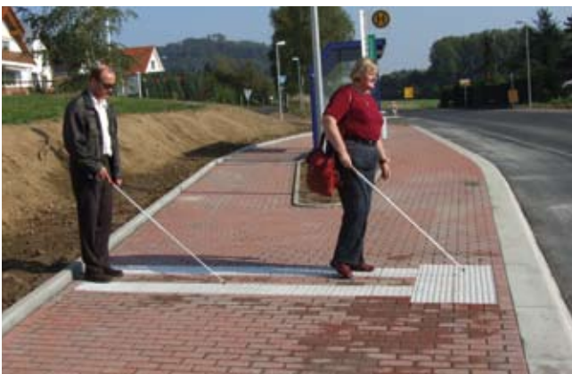
Der Auffangstreifen an der Haltestelle mit Pflasterstreifen in der Mitte lässt sich gut von dem an der Querungsstelle unterscheiden.
