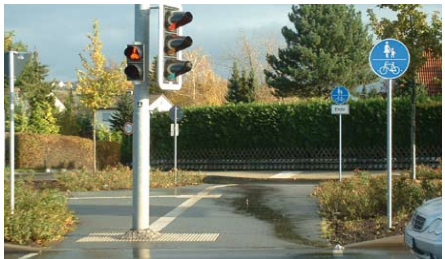
Das Leitsystem führt zur Querungsstelle an der Erschließungsstraße. In der Mitte der Abzweig zur Querungsstelle der alten Ortsdurchfahrt.
